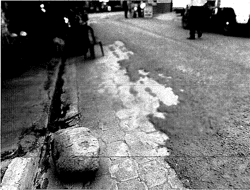
Estado deteriorado de la superficie de rodamiento es evidente, el adoquinado antiguo ya resalta
