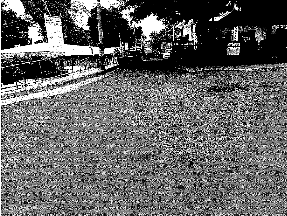
Estado deteriorado de la superficie de rodamiento es evidente, el adoquinado antiguo ya resalta
